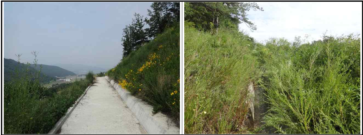
【그림 15.3.3】 배수시설 전경
